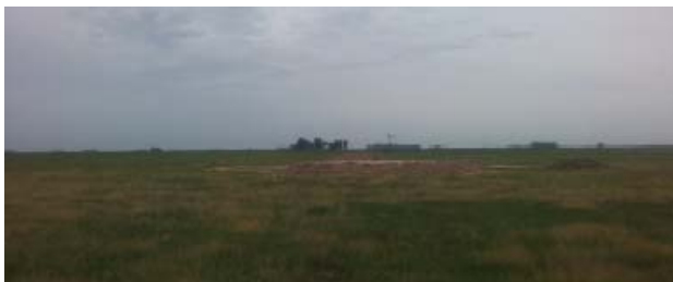
Trabajos en terraplén de tanque y molino solicitado a Ley Ovina UEP Bs As
